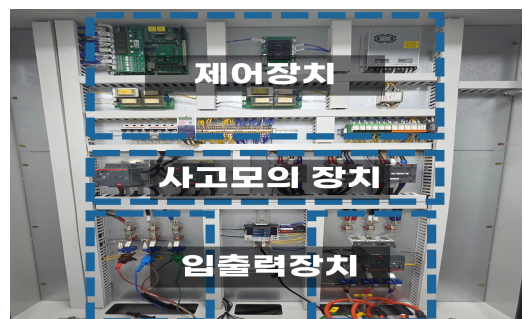
[그림 5] AC 전원 및 제어부 구성
